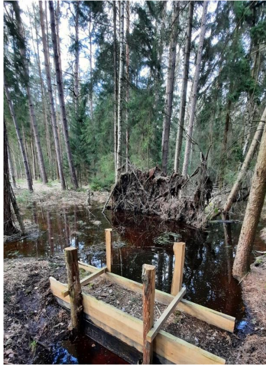
Abb. 2: Doppelwandiger Dammbau des Sachsenforstes mit Sägespäne-Zwischenfüllung zur Wiedervernässung der Torfflächen am „D15“, Aufn.: H. Oertel 4/2024
